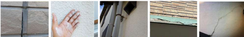
コーキングの劣化 チョーキング 鉄部のサビ 幕板の剥がれ 外壁のひび割れ
